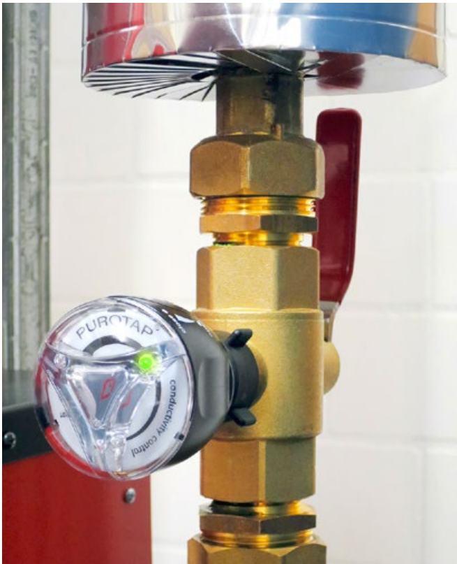
PUROTAP® i-control, das einfache und preiswerte Kontrollinstrument für die permanente Inline-Überwachung der Heizwasserqualität.
