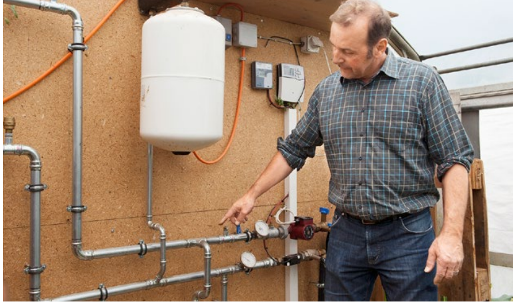
Regeltechnik von Tobler: Ruedi Aschmann erklärt, wie die Wärme des Biomeilers zu Heizenergie wird.
