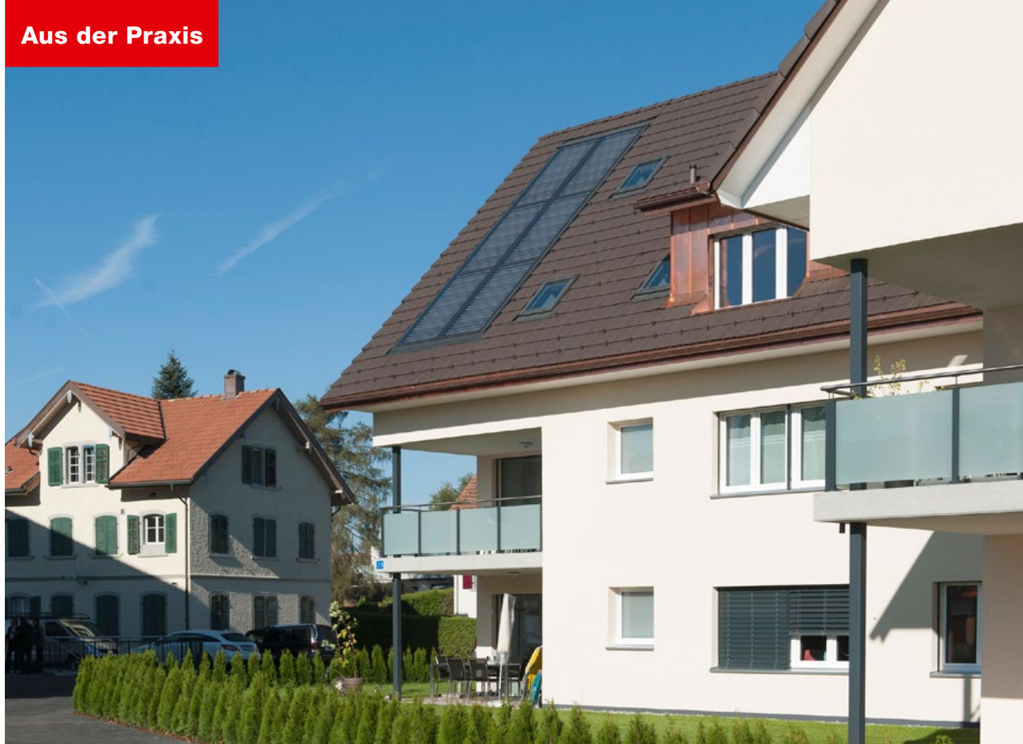
Dank thermischen Solarpannels auf dem Dach sparen die Mieter Heizkosten.
