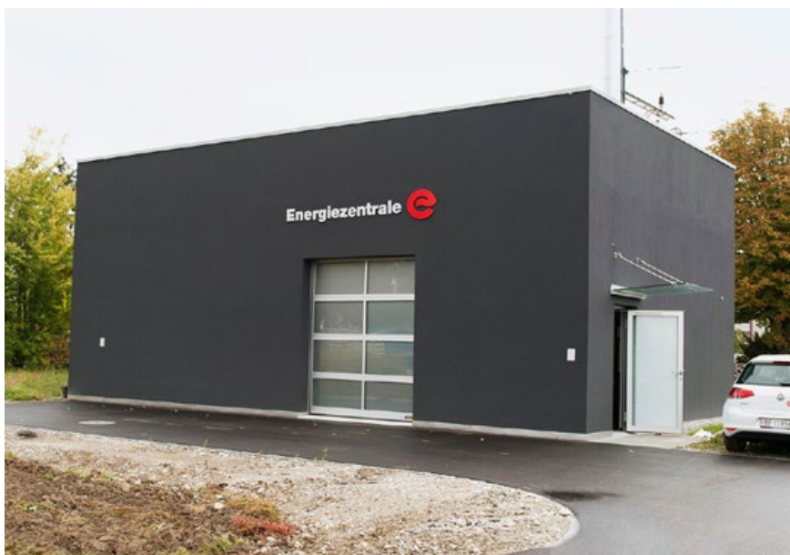
Die Energiezentrale ist ein wichtiger Knotenpunkt im Fernwärmeverteilnetz.
